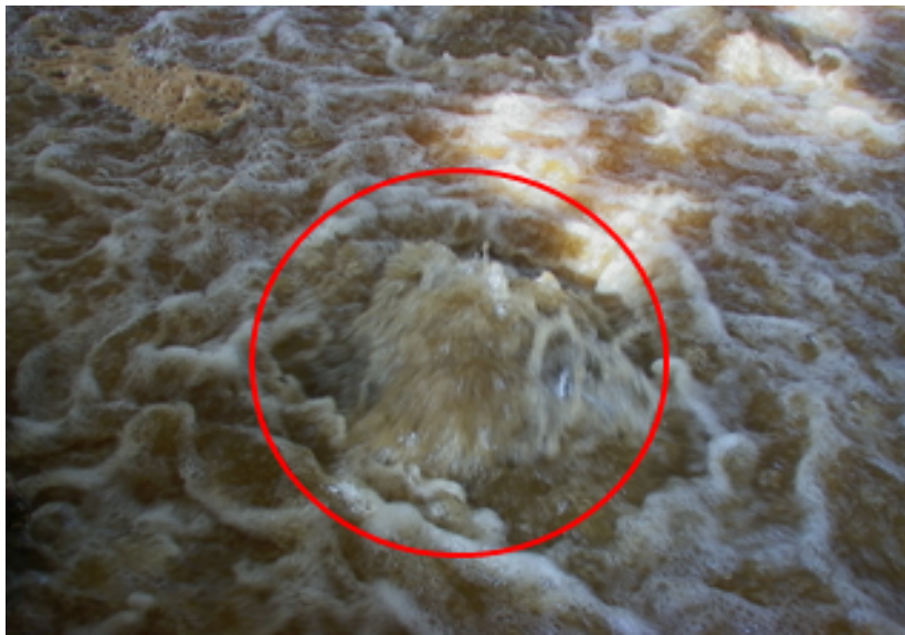
شکل ۲- نتیجه شکستن کلاهک نازل
