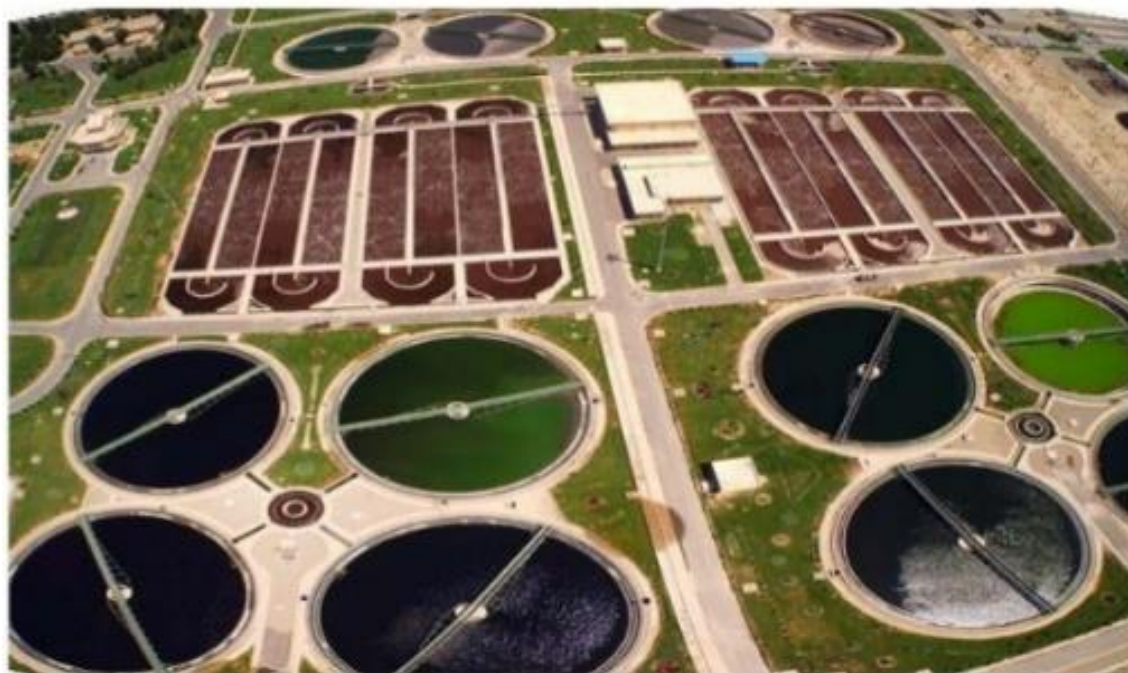
شکل ۴- نمای مدول‌های ۵ و ۶ تصفیه‌خانه فاضلاب جنوب تهران
