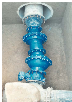
شکل ۱- اتصال قابل انعطاف DN ۳۰۰، محل نصب: شرکت آب و فاضلاب جنوب شرقی
