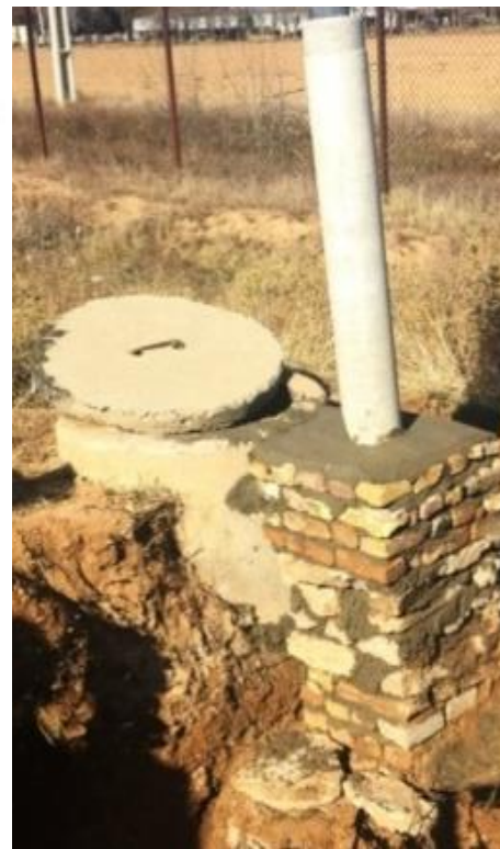
شکل ۴- لوله تهویه و هواکش عمودی آدمرو ریزشی خط انتقال فاضلاب شهر اراک در سال ۱۳۹۶
