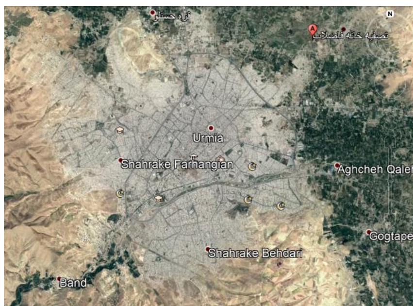
شکل ۱- تصویر هوایی تصفیه‌خانه فاضلاب
