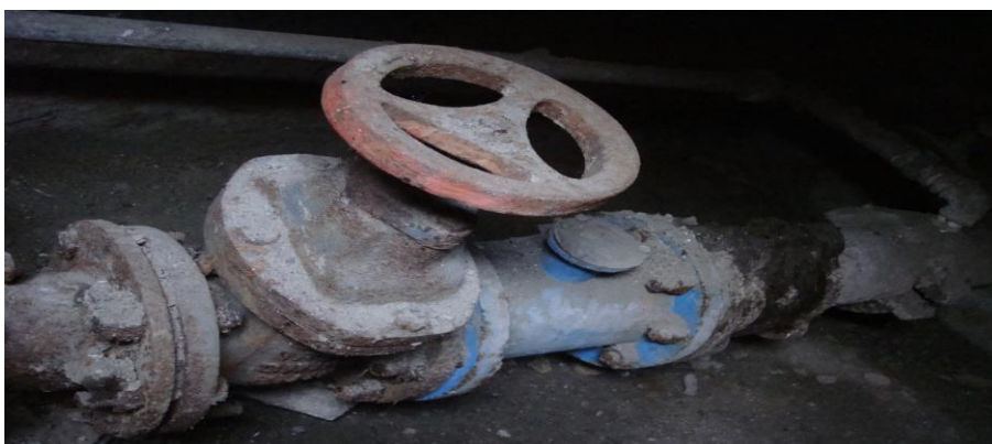
شکل ۵- عدم نگهداری مناسب از سنسور فلومتر الکترومغناطیسی
