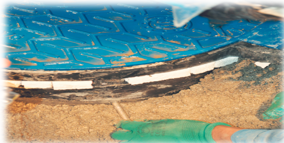
شکل ۳- جانمایی و نصب دریچه در سطح خیابان توسط شرکت فاضلاب تهران
