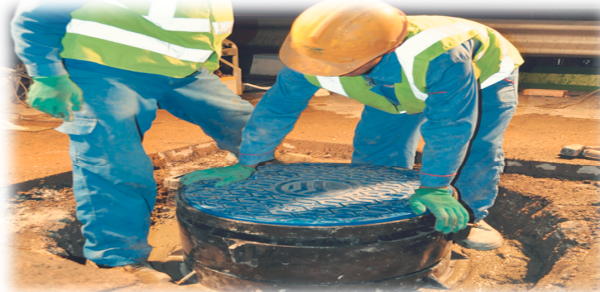
شکل ۳- جانمایی و نصب دریچه در سطح خیابان توسط شرکت فاضلاب تهران
