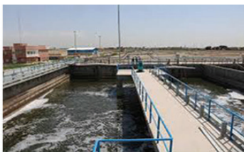
تصفيه خانه فاضلاب جنوبي غرب استان تهران ۱۳۹۶
