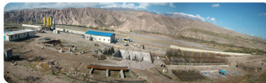
انتقال آب از سد گرمي چاي به ميانه در حال اجرا
