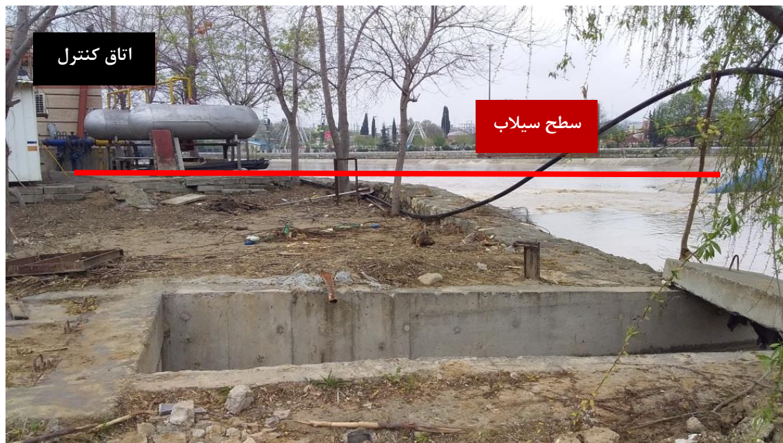
شکل ۷- تصویر مربوط به سطح سیلاب، اتاق کنترل و کمپرسورهای سد لاستیکی
