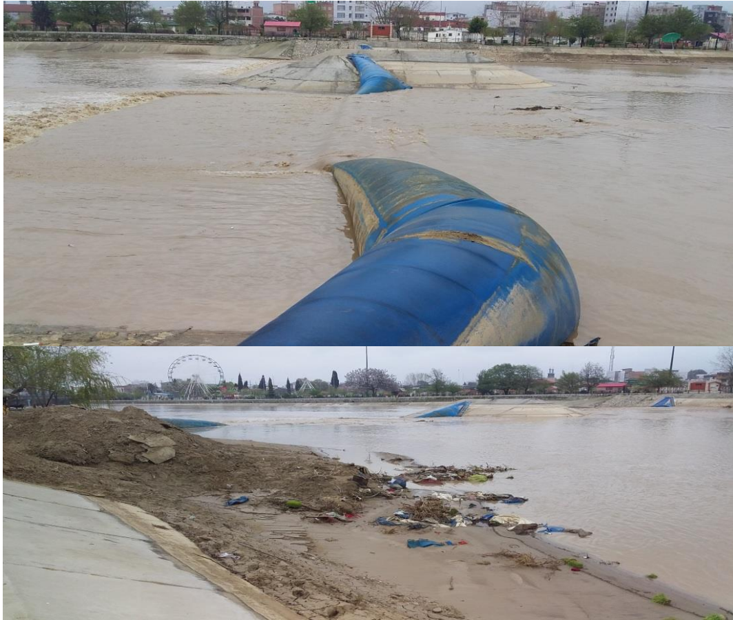
شکل ۹- تصاویر مربوط به سد لاستیکی تجن بعد از وقوع سیل
