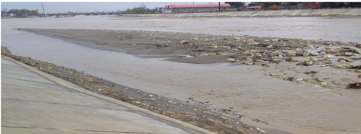
شکل ۱۰- رسوبات جمع شده در بالادست سد لاستیکی بعد از وقوع سیل
